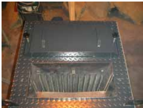
1. Avaa kattilan päällä olevat nuohousluukut.
