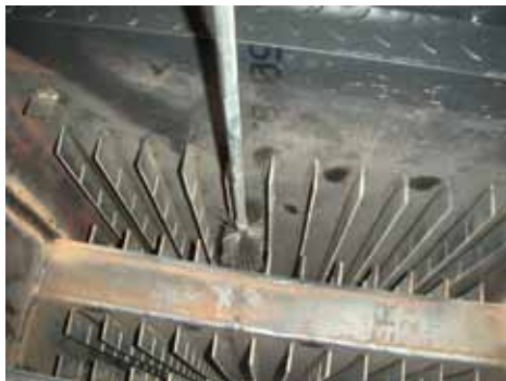
2. Kiinnitä harjaosa varteen ja harjaa sola kerrallaan.
