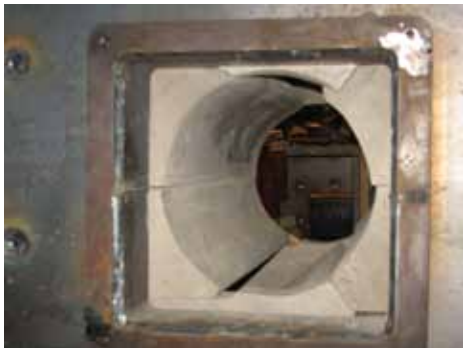
7. Sivutiilen yläosat 2 kpl (huom kätsisyys). Väli-aikainen tuki poistetaan, asennus on valmis.
